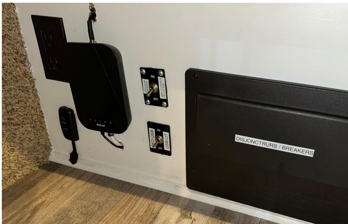
Emplacement de l'amplificateur et de son commutateur.
