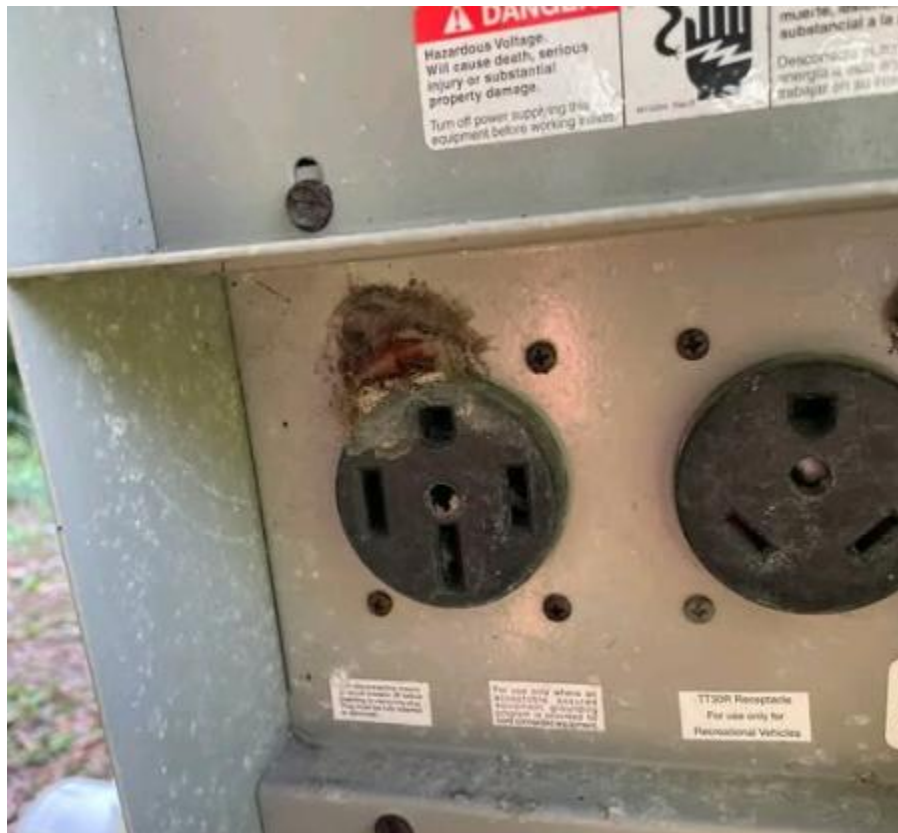
Exemple de dommages au connecteur 30A
